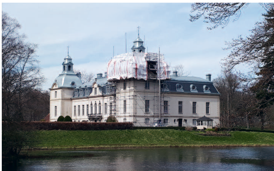
Kronovalls slott i Skåne genomgår en omfattande takomläggning. Slottet ingår i en av Riddarhusets fem domänstiftelser. FOTO: ANDERS ISLÉN.
