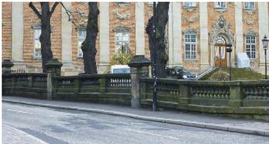
Man kan tydligt se att balustraden går i vågor samt att den är mycket nedsmutsad. Den naturliga färgen är ljusröd. FOTO: MARIE KLINGSPOR ROTSTEIN.
